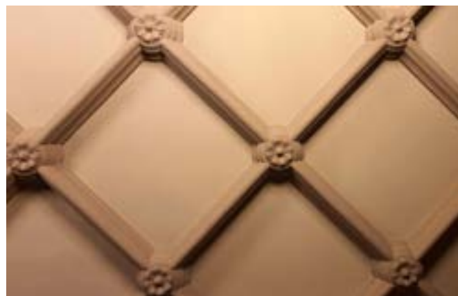
Bibliotekos virsmas: Retų leidinių skaityklos lubos prieš rekonstrukciją ir dabar, po rekonstrukcijos
