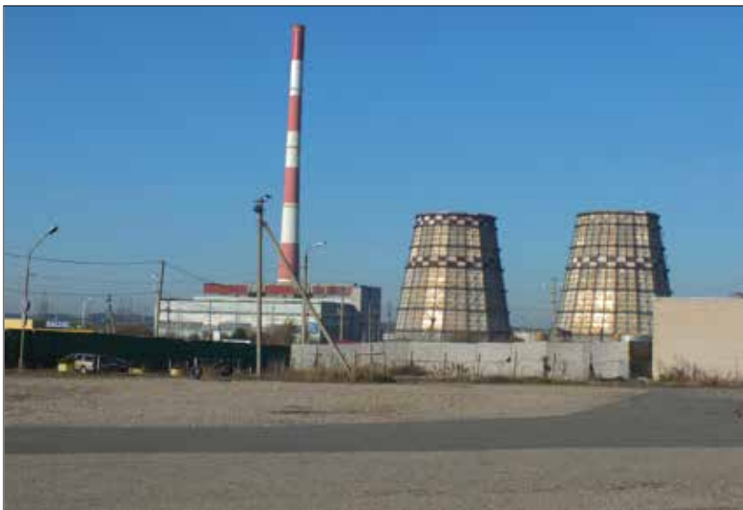
Vilniaus trečioji šiluminė elektrinė
